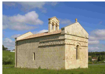
Etat de la chapelle de Tresséroux en 2002
